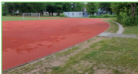
Zu Beginn wurden ca. 5.200 m<sup>2</sup> alter Kunststoffbelag samt Asphalt-Tragschicht ausgebaut und abgefahren. Der Abbruch der Randeinfassung, der Muldenrinnen sowie des Rohrsystems folgte. Ursprünglich sollte auch noch die bestehende Schottertragschicht ausgebaut und der darunter liegende Boden vermörtelt werden. Da beim Abbruch und dem dabei vorherrschenden Baustellenverkehr nichts Auffälliges am Baugrund festzustellen war, konnten diese kostenintensiven Arbeitsschritte jedoch
