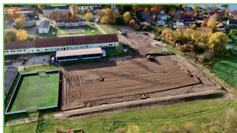
Rasenplatz in der Sanierungsphase (Foto: Fa. Schmitt)
