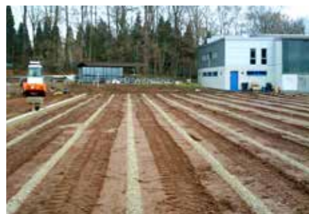
Verfüllung der Sickerschlitz
