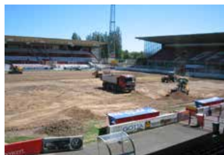
Verfüllung der Sickerschlitz
