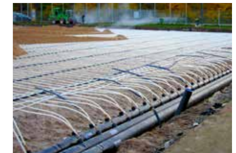
Moderne Technik unterstützt.
