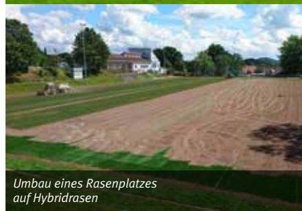
Die verlegten Kunstfasern zur Verstärkung der Rasentragschicht
