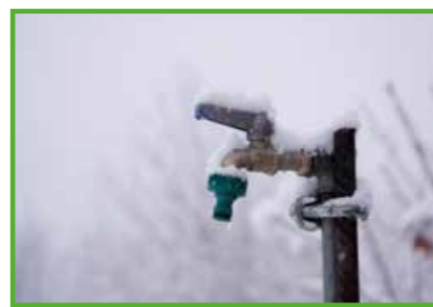
Bild 5: Wasserleitungen entleeren und sperren
