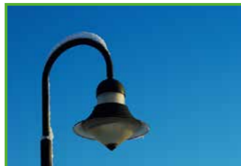
Bild 4: Elektroinstallationen müssen überprüft werden
