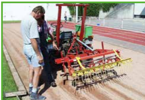
Bild 1: Auflockern des Belags
