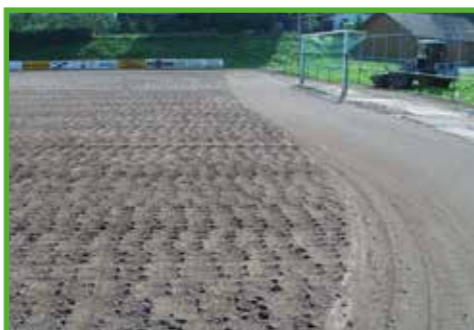
Bild 5: „Verzahren“ der Deckschicht mit der dynam. Schicht
