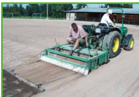
Bild 3: Einmischen und einarbeiten von Stützkornmaterial
